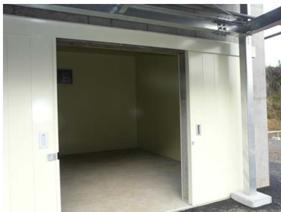
密閉試験場内部
