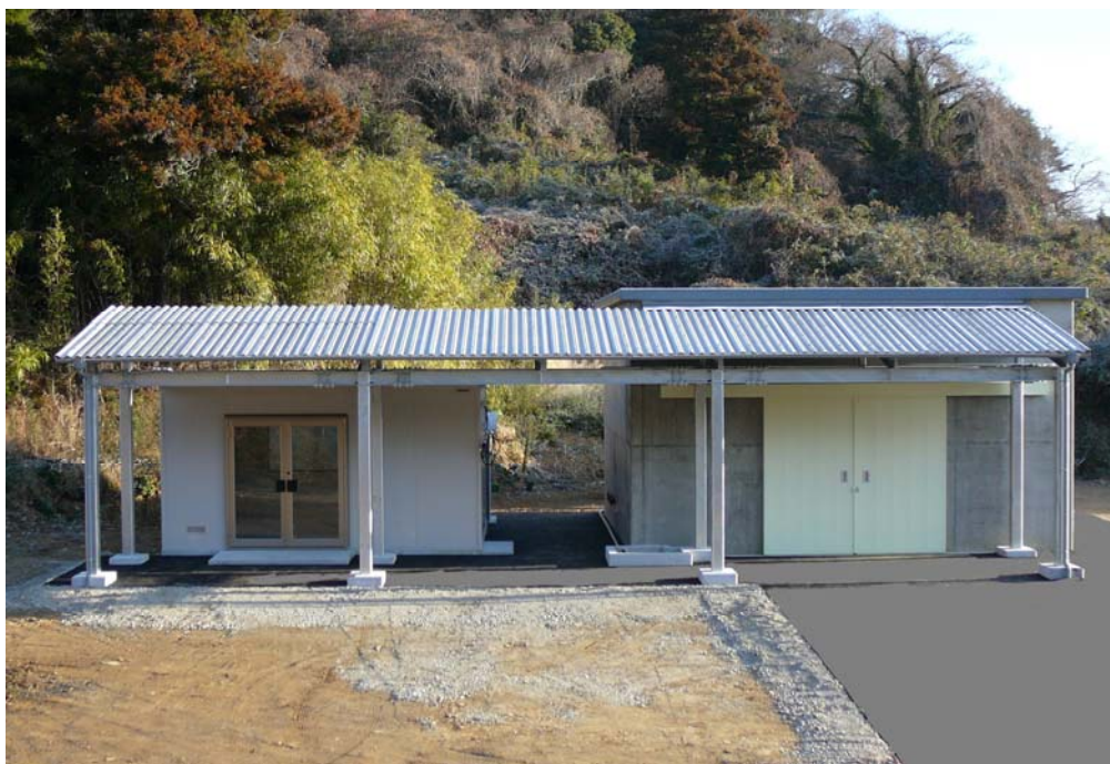
計測室（左側）及び 密閉試験場（右側）
