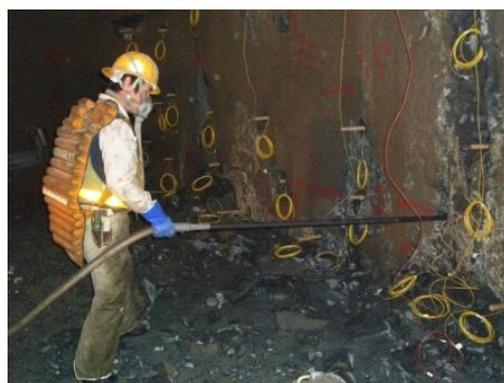
装填機による装薬風景
